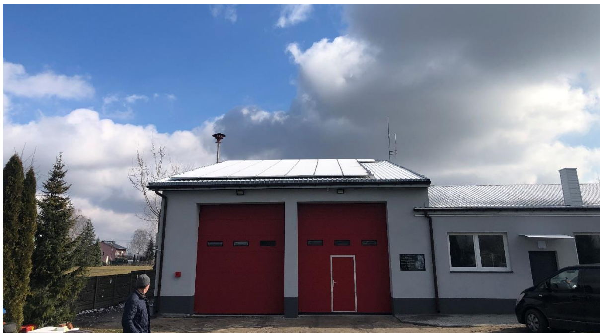
Termomodernizacja remizy OSP Cielce
